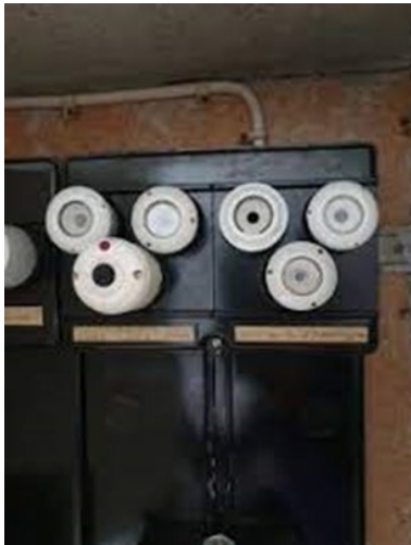
Unterverteilungen mit Schraubsicherungen, veraltete Klingel- und Gegensprechanlagen
