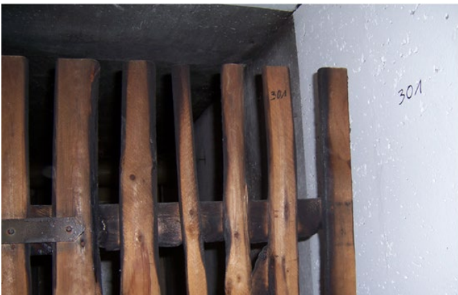
Fehlende Kellerdeckendämmung
