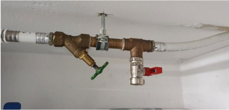
Absperrhähne in Mieterkellern (Anwesenheit erforderlich)
